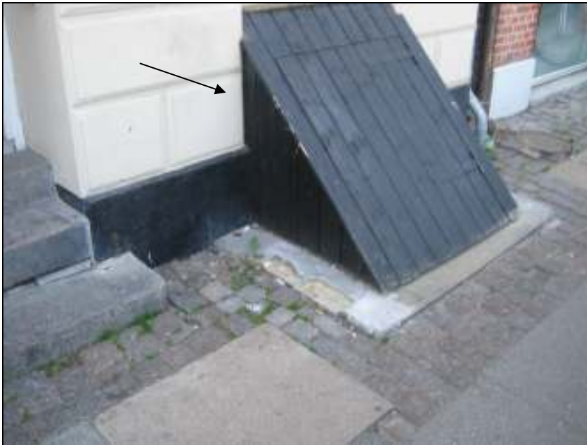
Kældernedgang på Blegdamsvej sløjfes.
